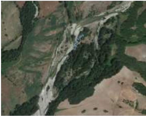
Figura 7.24 – Fiora – zona di Manciano-Soriano a monte del p.te SR74 (Fonte: Google Maps).
