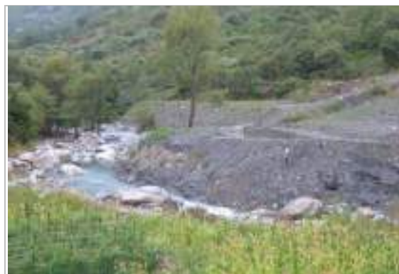
Figura 7.34 – Fiume Noce in località Parrutta – C.da Zillona. Ostruzione d'alveo prodotta da un cumulo di frana (Fonte: Autorità di bacino della Basilicata, 2015)
